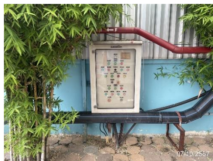
ภาพที่ 2.2-13 ตู้ควบคุมไฟฟ้าของระบบบำบัดน้ำเสีย
