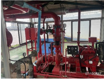
ภาพที่ 2.2-24 ปัมป์สูบน้ำดับเพลิง
